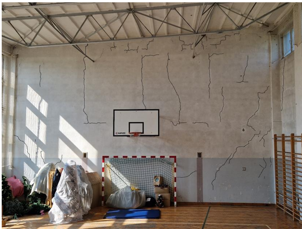
Fot. 4. Widok zarysowań ściany zachodniej sali gimnastycznej.
