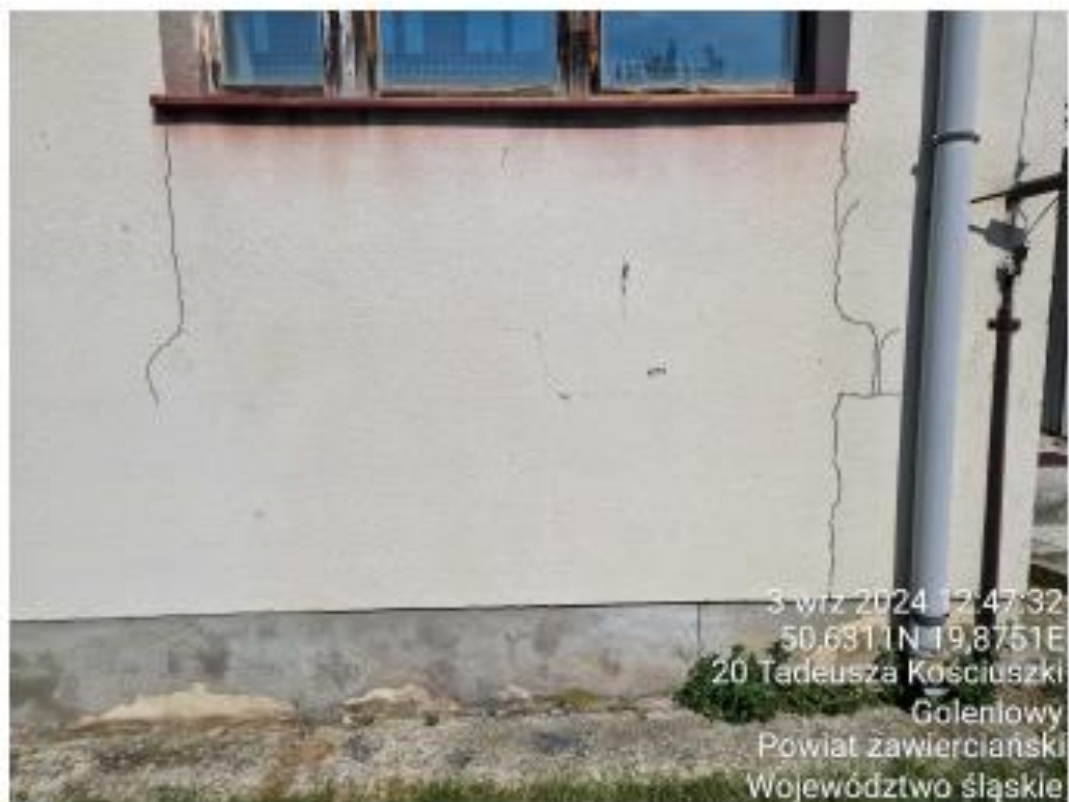
Fot. 15. Widok zarysowań elewacji południowej od strony wschodniej ściany szczytowej.
