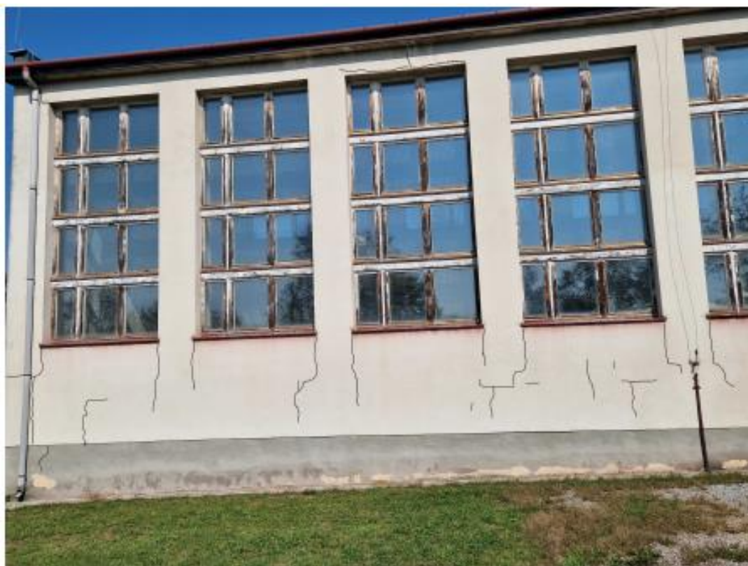
Fot. 14. Widok zarysowań elewacji południowej cz. I.
