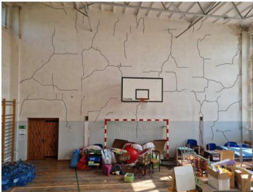
Fot. 1. Widok zarysowań ściany wschodniej sali gimnastycznej.
