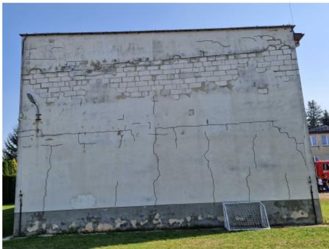
Fot. 7. Widok zarysowań elewacji zachodniej sali gimnastycznej.
