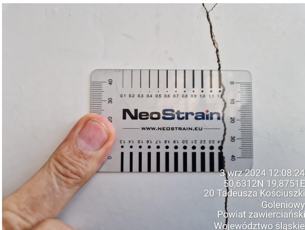
Fot. 3. Pomiar zarysowań ściany wschodniej od strony okien.
