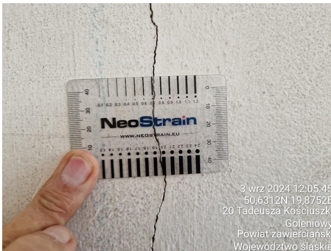
Fot. 2. Pomiar zarysowań ściany wschodniej od strony wejścia.
